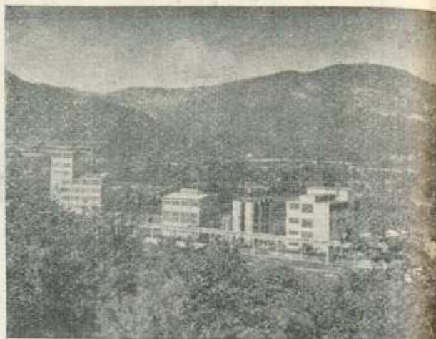
POGLED NA POSTROJENJA ZA PROIZVODNJU \text{HNO}_3
