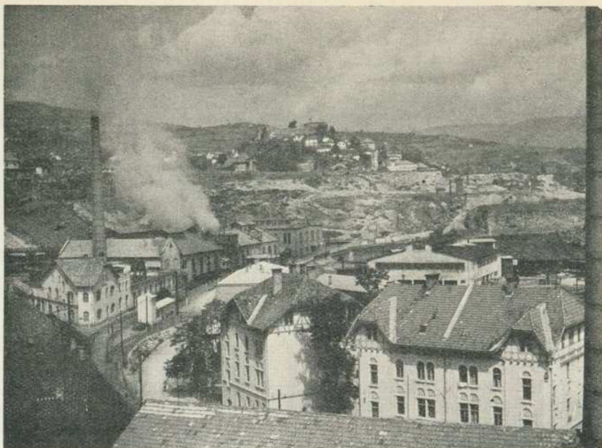
TVORNICA „ELEKTROBOSNA“ JAJCE
