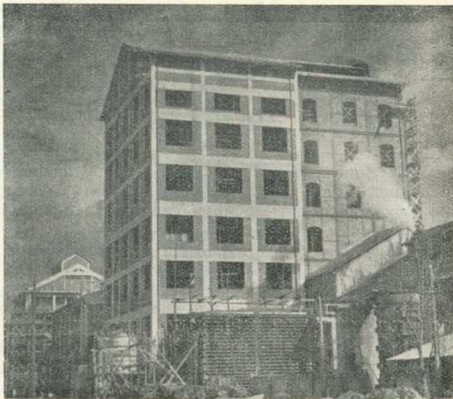
GLAVNI DIO POGONA ZA PROIZVODNJU SIROVOG BIKARBONATA
