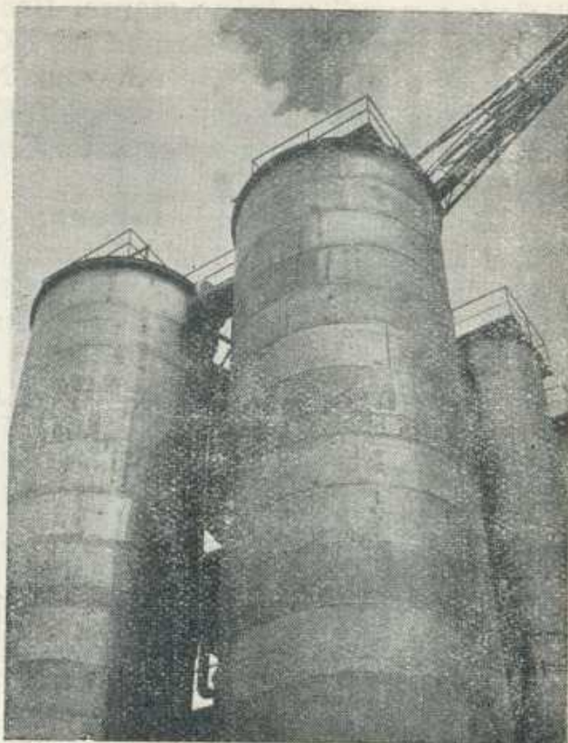
KOLONE ZA APSORCIJU I OKSIDACIJU NITROZNIH GASOVA
